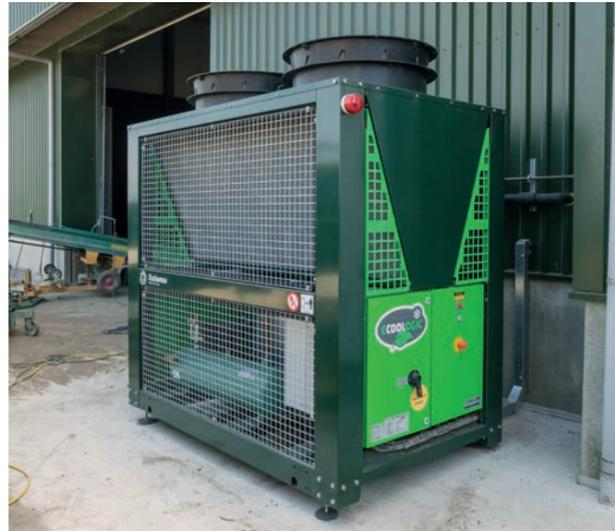
indirect permet de réfrigérer plusieurs cellules à différentes températures. Le GCU-I est disponible avec des puissances frigorifiques comprises entre 65 et 570 kW et dispose d'un ou plusieurs circuits de refroidissement. Le système de refroidissement peut être configuré pour se conformer aux dispositions fiscales (nationales) qui stimulent l'efficacité énergétique.
